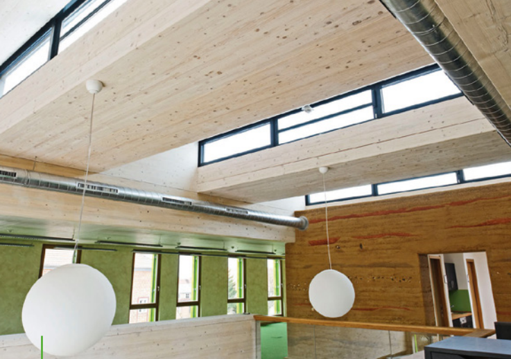
Innenansicht FNR Neubau
