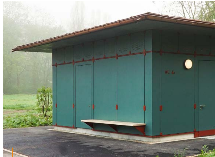
Oben: Wasserspeier | Unten: Bedürfnisanstalt im Park an der Ilm
