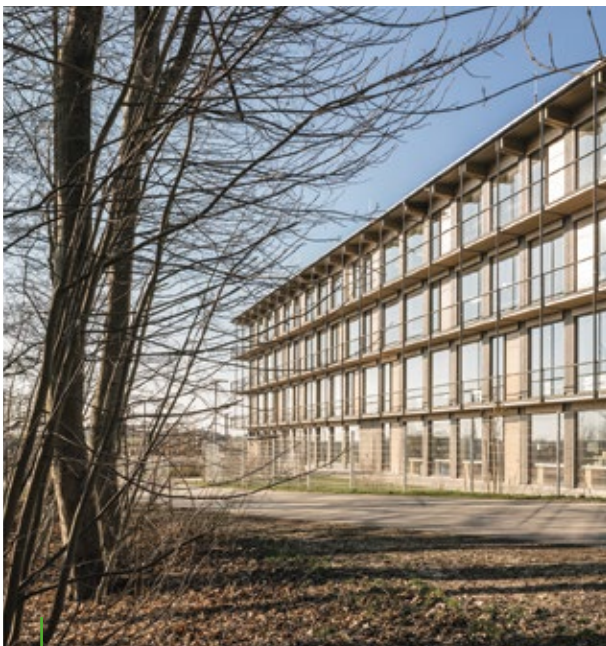
Fassade – Ostseite mit umlaufenden Fluchtbalkonen
