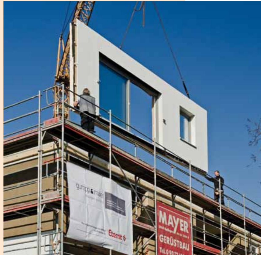
Montage der vorgefertigten Fassadenelemente / Foto: Eckhart Matthäus
