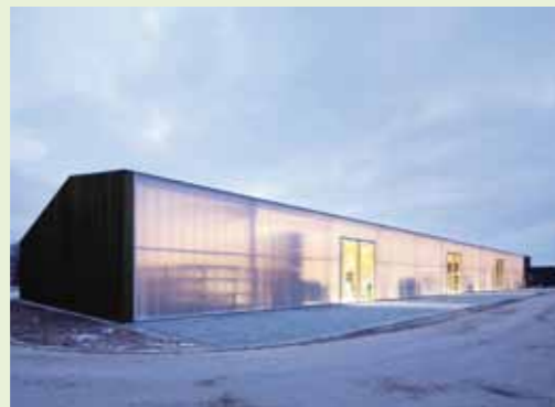
oben: LKW-Anfahrt / unten: Außenansicht
