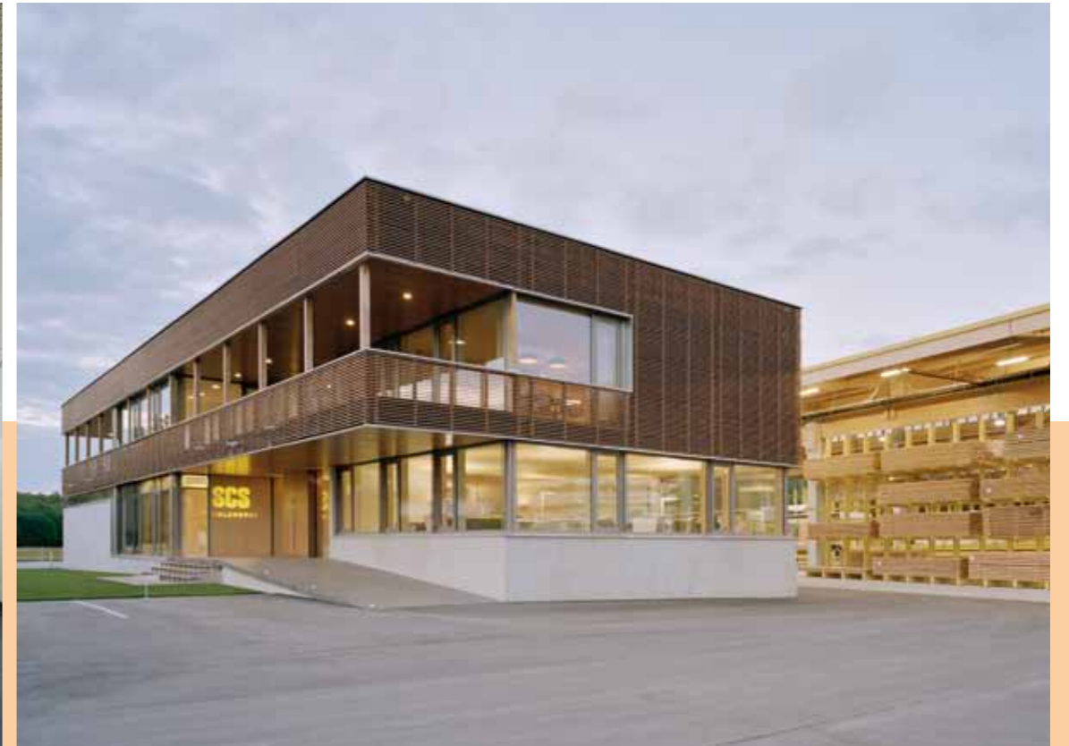
Verwaltungsgebäude und Lagerhalle im Hintergrund / Fotos: Brigida Gonzalez
