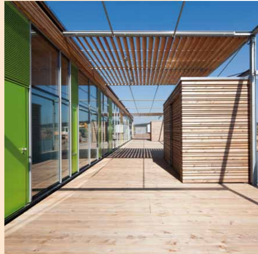
Holzterrasse auf der Ostseite
